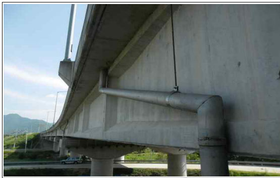
국도24호선방향 배수관 전경
