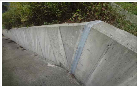
사면(중점부) STA.0-5 배수로 이격 보수
