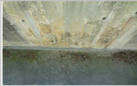
사면(시점부) STA.0+0 배수로 이격 보수
