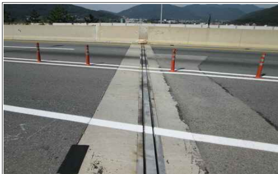
상행선 A1 신축이음 전경
