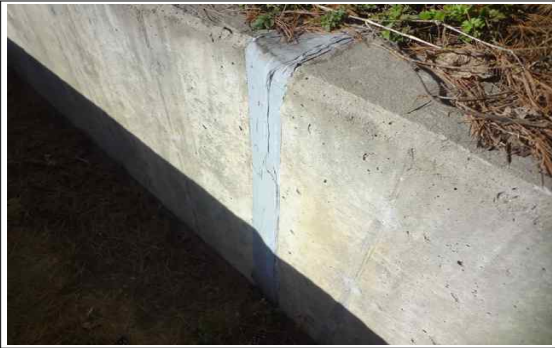
사면(시점부) STA.0+10 배수로 이격 보수
