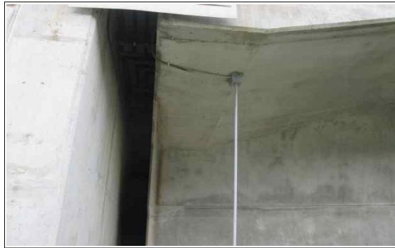
상행선 S1 (A1측) 유도배수관 길이부족 보수 현황
