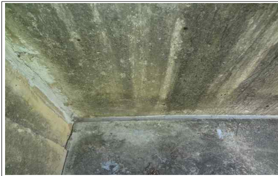
사면(시점부) STA.0-10 배수로 이격 보수
