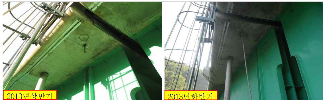
상행선 S3 (P3측) 유도배수관 배수관 길이부족 보수 전·후 현황
