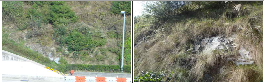
사면(시점부-우측) STA.41+710 1단 암노출
