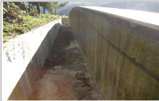
사면(시점부) STA.0+20 배수로 이격 보수
