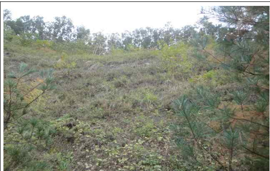
사면(중점부) STA.0-20 2단 녹생토유실
