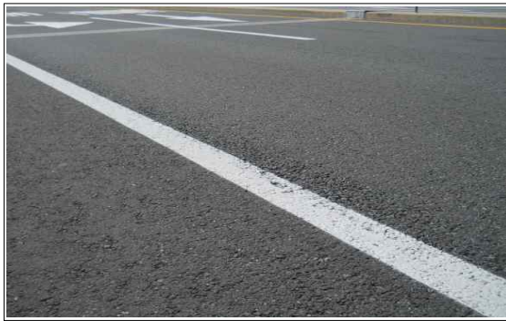
국도24호선방향 S2 교면포장 라벨링
