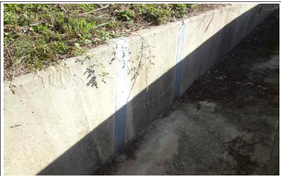
사면(시점부) STA.0-20 배수로 파손 보수
