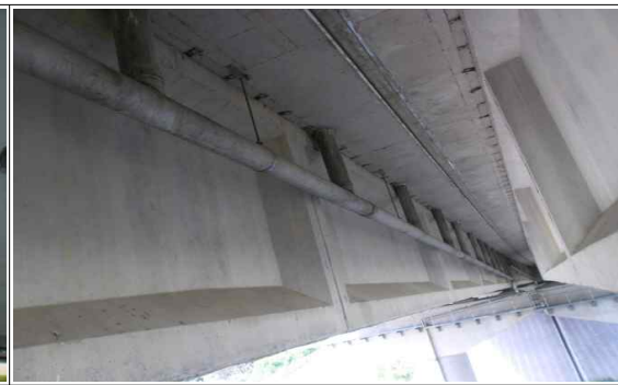
북밀양IC방향 배수관 전경
