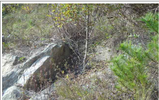
사면(시점부-좌측) STA.38+540 2단 표층유실
